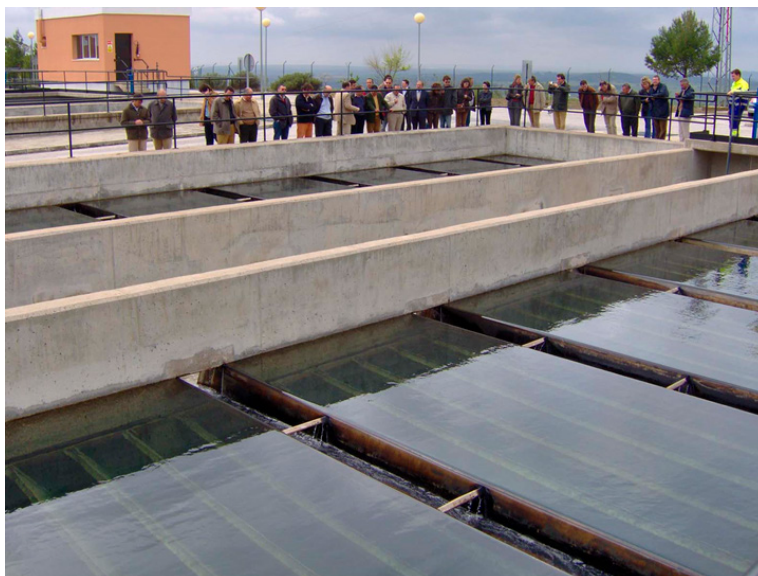
Figura 67. Vista de la ETAP "Las Chimeneas". Fuente: Portal de la Diputación de Sevilla.
